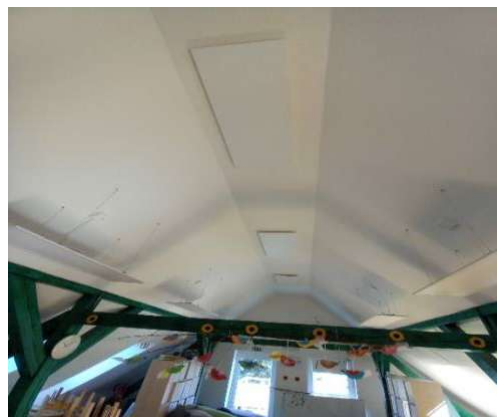
Obrázek 72 – Stropní infrapanely
