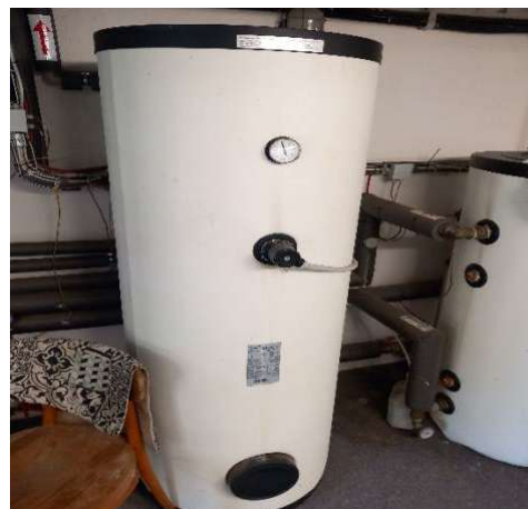
Obrázek 36 – Zásobníkový ohřivač TV
