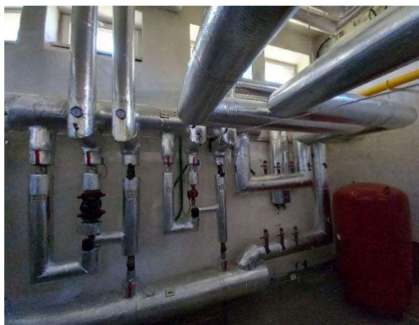
Obrázek 61 – Sběrač a otopné větve
