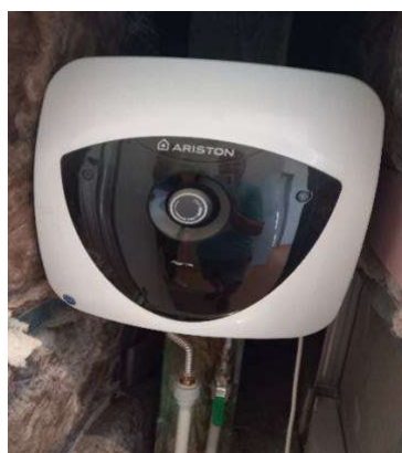
Obrázek 74 – Zásobníkový ohřivač Ariston
