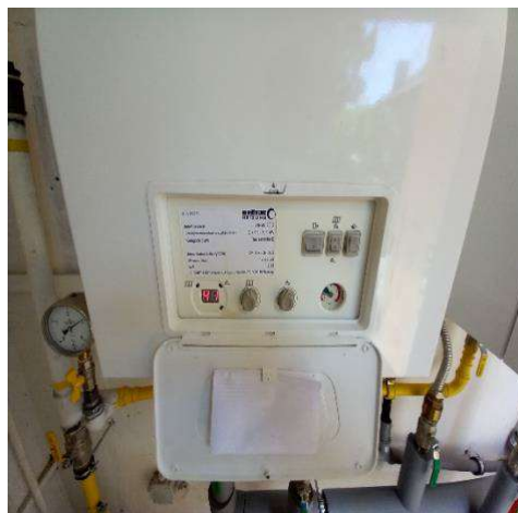
Obrázek 90 – Kondenzační kotel
