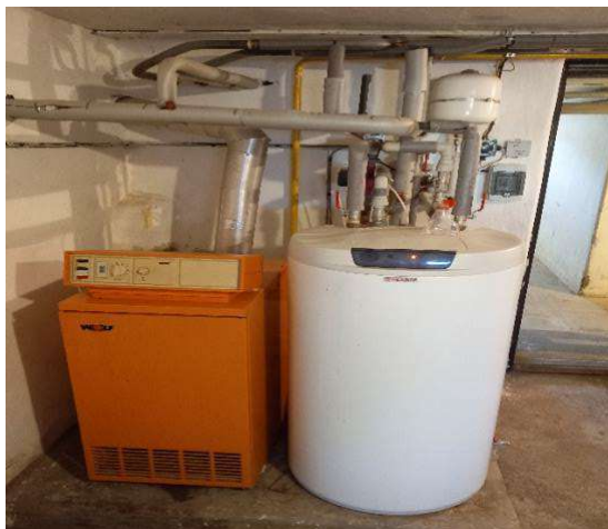
Obrázek 51 – Kotelna s pohledem na kotel a zásobníkový ohřívač
