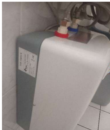
Obrázek 8 – Příprava TV pro kuchyňku
