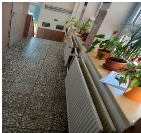
Obrázek 44 – Otopná tělesa s TRV
