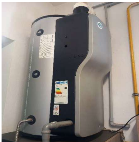
Obrázek 45 – Plynový ohřívač TV Innovo
