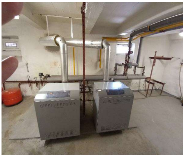
Obrázek 41 – Kotle pro HZ
