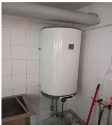
Obrázek 73 – Zásobníkový ohřivač Dražice
