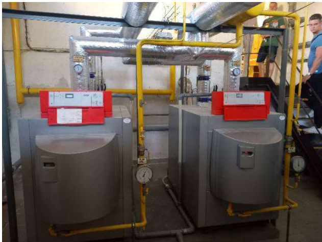
Obrázek 58 – Kotle Viessmann
