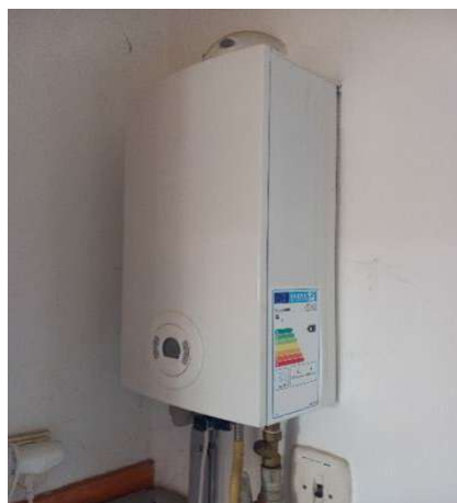
Obrázek 46 – Plynový ohřívač TV Junkers
