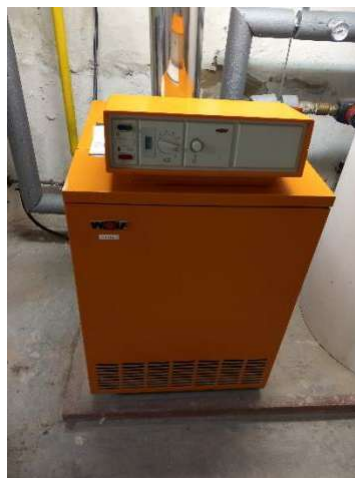
Obrázek 81 – Záložní plynový kotel
